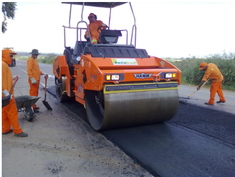
2014 – 2016: o legado de obras de infraestrutura
