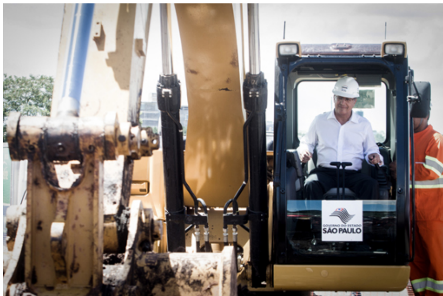
Alckmin dá início às obras do Rodoanel Norte
