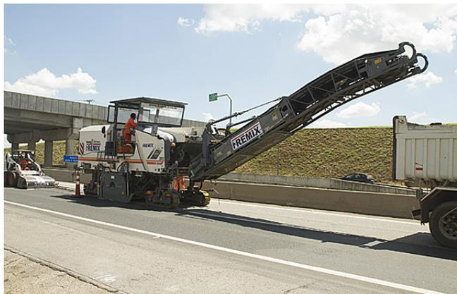
Técnica de microfresagem garante recuperação rápida e econômica, além de baixa interferência no tráfego
