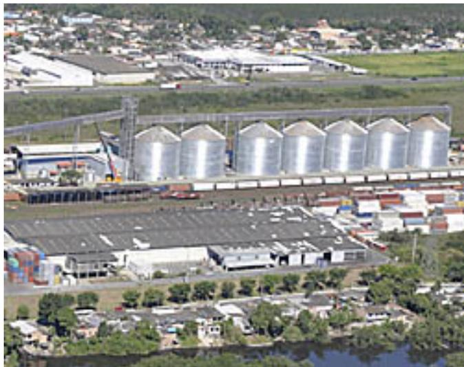
O novo Terminal Intermodal de Armazenagem da empresa Terminal Portuário Seara, do Grupo Seara, está equipado com sete silos metálicos produzidos pela Armco Staco, projeto que amplia a capacidade de estocagem de grãos no Porto de Paranaguá, no Paraná. A planta, inaugurada em abril de 2013, já está operando com capacidade máxima: 80 mil toneladas de soja para exportação, distribuídas em sete silos com 27 metros de diâmetro e 30 metros de altura cada.
