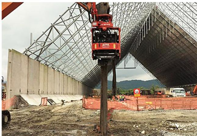
A Getefer entregou dois MOVAX modelo SG 60V para a VPA Equipamentos que foram instalados em escavadeiras Doosan 340. Sendo o primeiro em fins de outubro de 2015 e o segundo em fins de dezembro de 2015.
