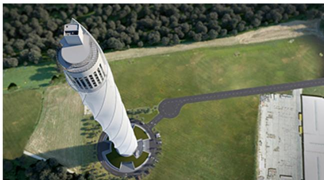
Com pêndulo de 240 toneladas, instalado a 193 metros, será possível simular as vibrações naturais dos edifícios e testar os sistemas de elevadores em condições reais. Seja o Burj Khalifa, nos Emirados Árabes; o One World Trade Center, nos EUA; ou um novo arranha-céu em construção, a torre de teste da thyssenkrupp Elevator, em breve será capaz de imitar as vibrações naturais vividas por qualquer edifício devido ao vento.
