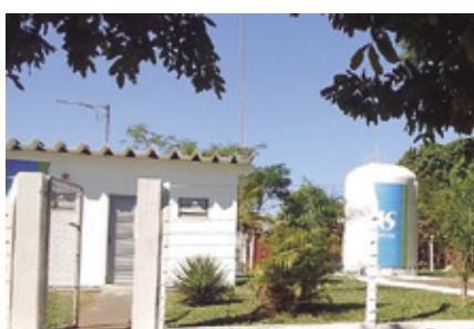
Reservatório Rubineia RT
