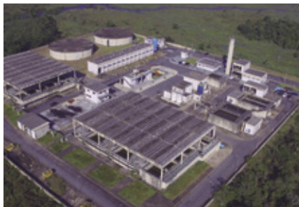
ETA Jurubatuba - Guarujá Q=2,2m^3/S
