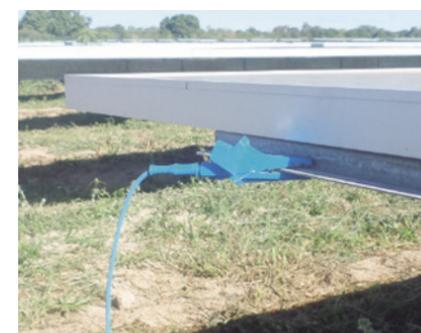
Figura 16 - Detalhe de instalação aterramento de carcaça do PVCHECK
