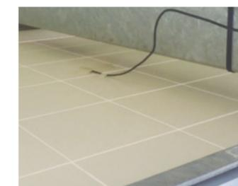
Figura 19 - Detalhe de instalação do sensor de temperatura
