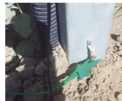
Figura 15 - Detalhe de instalação aterramento principal do PVCHECK
