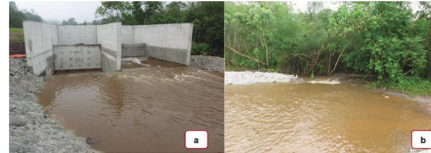
Foto 8 - Operação de teste de uma linha adutora - Fase Construtiva: (a) Vista de Montante; (b) Vista de Jusante com lançamento no córrego Taiaçupeba-Mirim
