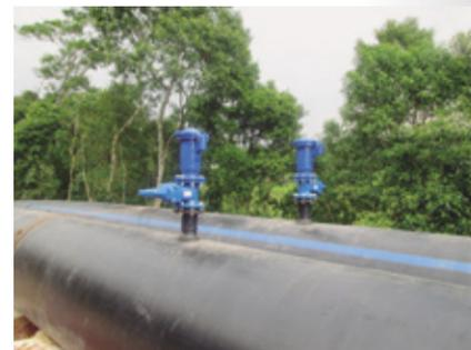
Foto 6 - Ventosas Tríplice-Função instaladas
