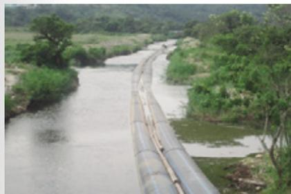
Foto 4 - Tubulação desfilada em trecho aquático
