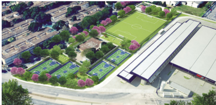
Figura 11 - Vista geral da área de intervenção, observando-se a direita o atual terminal de ônibus e respectiva ampliação, e ao centro a unidade básica de saúde em funcionamento no local
