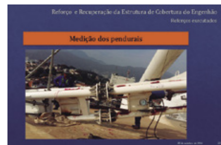
Figura 9 - Realização da medição de cargas em elementos estruturais
