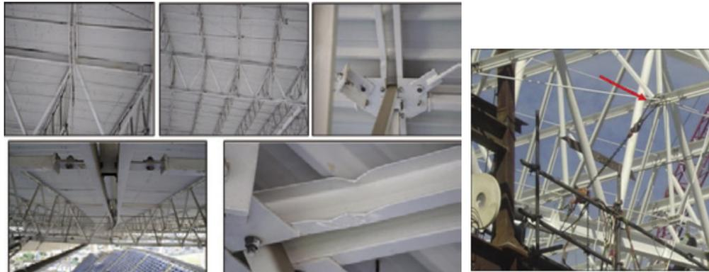
Utilização de cabos de aço e titor para forçar encaixes dos elementos, o que provocou desalinhamento de treliças, flambagem localizada e esmagamento de peças da estrutura decorrentes do procedimento de montagem do Consórcio Engenhão
