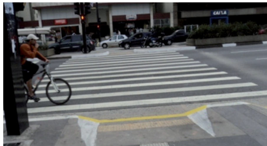
Faixa para pedestre nas travessias das pistas
