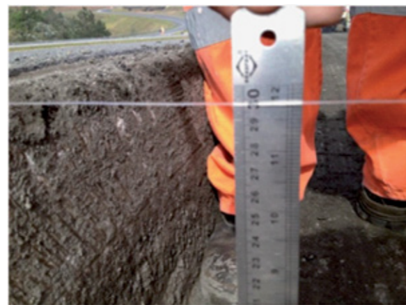
Fresagem na espessura de 30 cm em uma única passada
