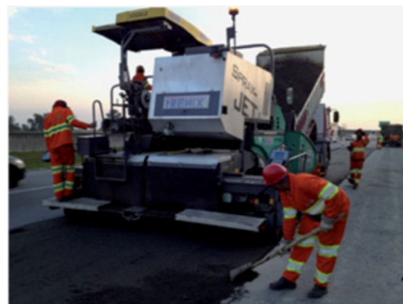
Aplicação do material reciclado na pista
