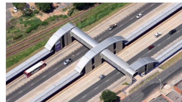
Estação de Transferência Anhanguera – Campinas
