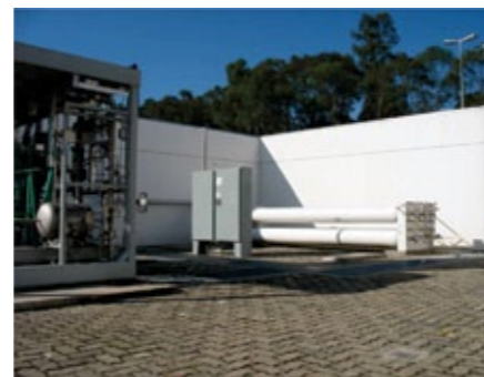
Estação de produção e abastecimento de hidrogênio (à esquerda, o compressor, que eleva a pressão do hidrogênio obtido a 430 bar; à direita, os tanques de armazenagem)
