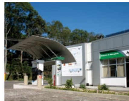
Vista da estação de produção e abastecimento de hidrogênio (à frente, o abastecedor)
