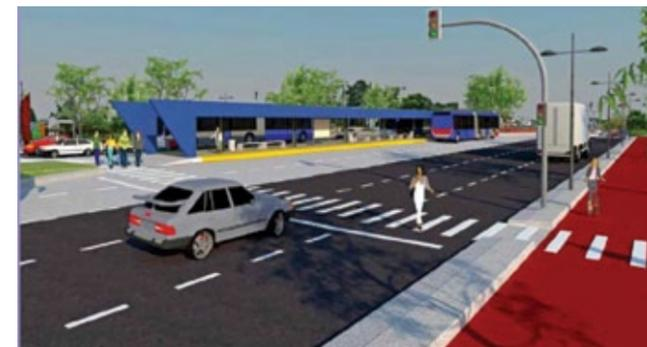
Figura 22 - As estações de embarque são estruturadas por dois pórticos metálicos
