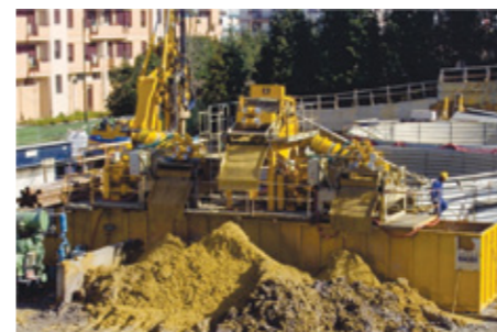
Material de escavação localizado junto ao "desarenador"
