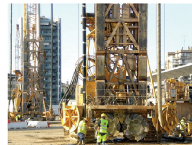
Equipamento de hidrofresa Bauer BC 40
