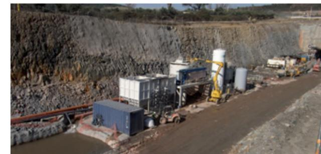
Figura 11 - Estação de tratamento 510 m³/hora
