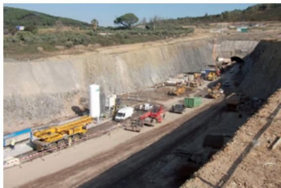
Figura 1 - Estação de tratamento inicial para o tratamento de 35 m<sup>3</sup>/hora
