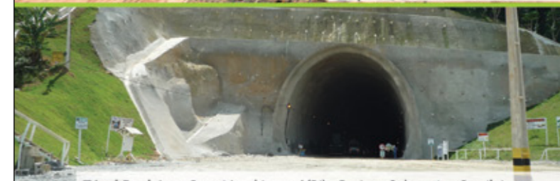
Túnel Estaleiro e Base Naval Itaguaí (RJ) - Projeto Submarino Brasileiro
