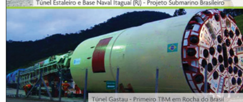
Túnel Gastau - Primeiro TBM em Rocha do Brasil
