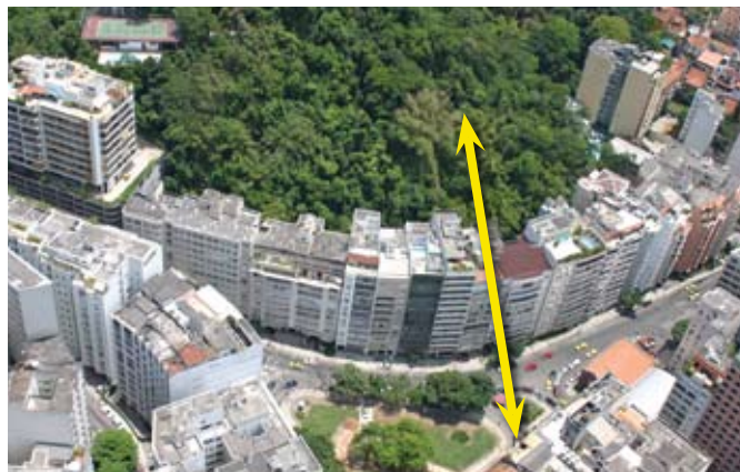
Vista aérea dos edifícios sobre o túnel de acesso
