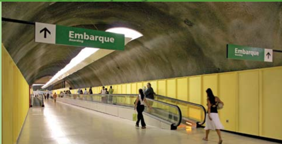
Túnel de acesso à Estação Cantagalo
