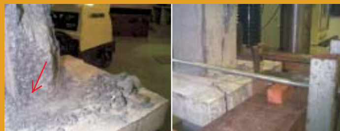
Figura 19 e figura 20 - Esmagamento da região da interface pilar-laje (3-50-35) e fissura na laje e no pilar superior (3-50-35)
