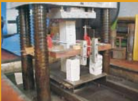
Figura 14 - Travamento finalizado com os tirantes de aço colocados no modelo I-50
