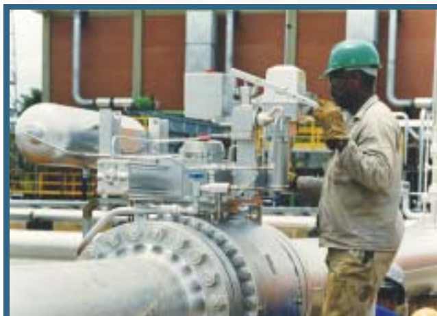
Estação de compressão de gás em Biguaçu (SC)
