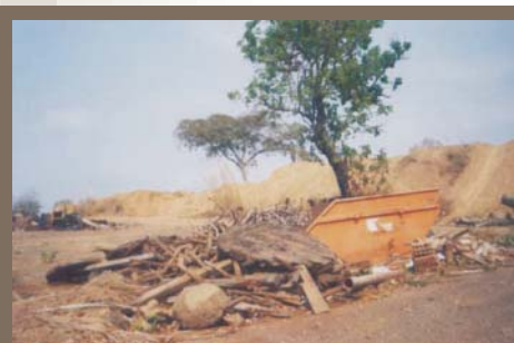
Depósito de entulho da empresa "C"
