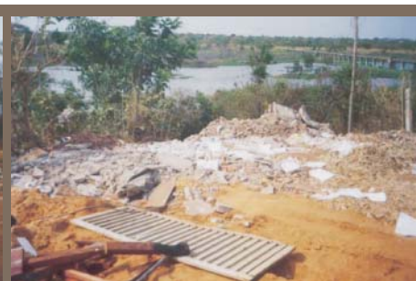
Nova disposição na área da empresa "C", avançando em direção ao Lago da Hidrelétrica Luiz Eduardo Magalhães, em Palmas (TO)
