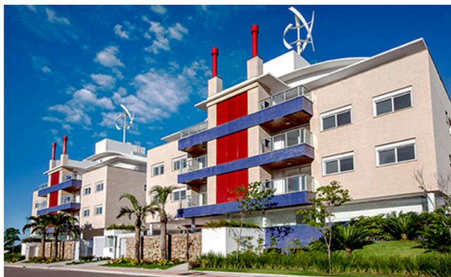
A energia eólica que capta a energia dos ventos via hélice de eixo vertical funciona com eficiência associada às placas coletoras solares e garantem 100% da água quente dos apartamentos e áreas de convivência, em dois edifícios de três andares situados na praia do Novo Campeche, em Florianópolis (SC).
