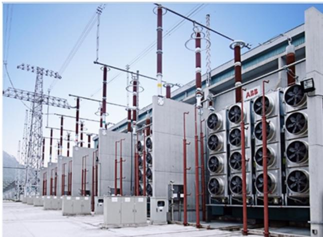
ABB irá permitir que dois novos links de transmissão UHVDC de 800.000 volts de longa distância transportem 8.000 megawatts cada
