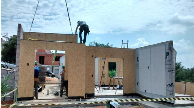
Tecnologia internacional para construção de casas chega para atender eixo Campinas-Jundiaí. Uma casa de 200m<sup>2</sup> em um dia e meio. Essa é a realidade do sistema construtivo Tecverde, que tropicalizou a tecnologia wood frame amplamente utilizada no exterior e se instala no interior de São Paulo. Para apresentar a tecnologia ao mercado paulista, a empresa pioneira no sistema, faz um Show Home em Vinhedo (SP) com a montagem de uma casa Slim em tempo real.
