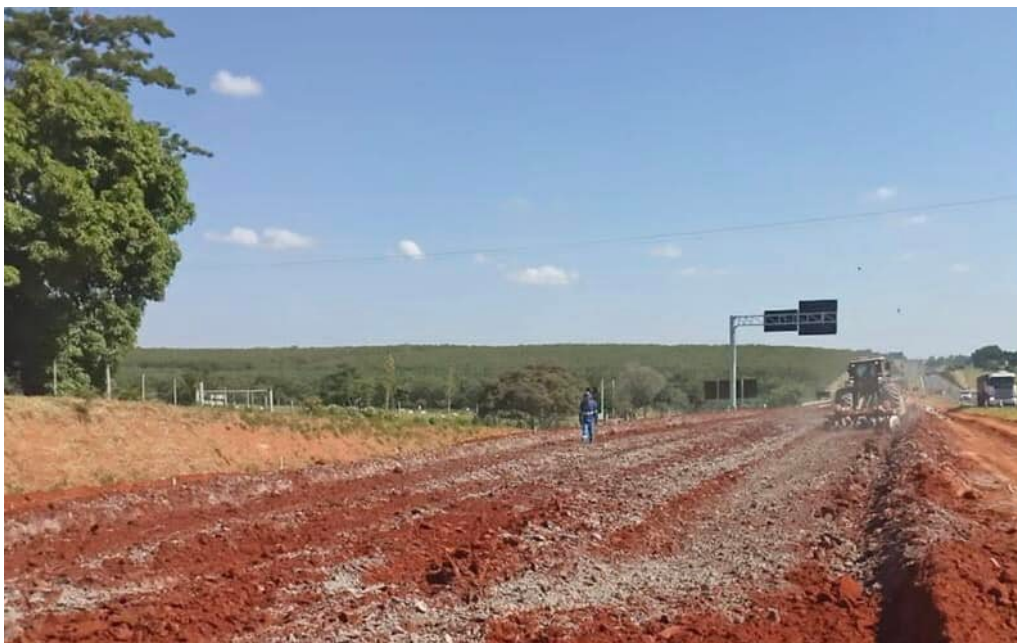
Eixo SP segue com obras para reconfiguração de pista na SP-425 Manutenção na pista causa interdição no sentido Sul.
