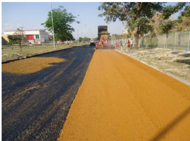
A usina de asfalto da Craft Engenharia vem desenvolvendo experimentos de produção e aplicação de asfalto colorido, em parceria com o Laboratório de Misturas Asfálticas do Programa de Engenharia Civil do COPPE. Como já ocorre em outros países, a utilização de pigmentos na mistura asfáltica tem a finalidade de sinalizar vias especiais e oferecer maior segurança aos motoristas. Um trecho de 3 mil metros na Ilha do Fundão, no Rio de Janeiro já foi pavimentada de amarelo
