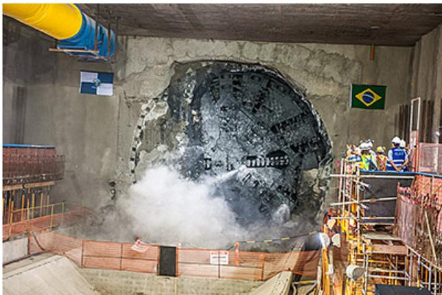
Equipamento alemão, que constrói o túnel enquanto escava, atravessou a parede de uma estação pela primeira vez
