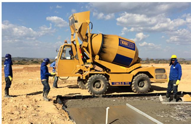
A autoconcreteira Carmix leva 30 minutos para produzir 3 metros cúbicos de concreto. Antes, a quantidade produzida era de apenas 0,4 metros cúbicos
