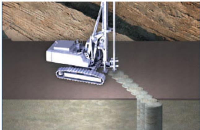
Líder mundial em serviços de fundação e engenharia geotécnica, a KELLER BRASIL promove o workshop “Reforço de Solos Moles: O Estado da Arte”, sobre a tecnologia de reforço de solos compressíveis com destaque para a técnica DSM – deep soil mixing, conhecida como coluna de solo-cimento
