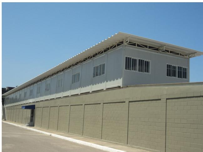
Sistema inteligente permite levantar construções com muito mais rapidez que nas construções tradicionais de alvenaria; Módulos e containers de aço se destacam por serem reaproveitáveis e poupam o meio ambiente
